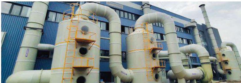
废气处理系统 waste gas treatment system
